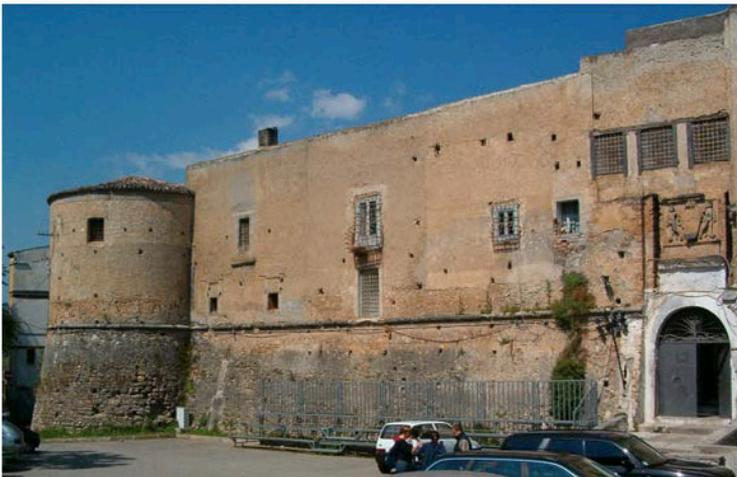
La cortina che aveva in origine piccole e rade aperture e, come del resto ha tuttora, un unico ingresso, munito una volta di ponte levatoio, affondava le sue radici in un vallo più o meno profondo, a seconda delle accidentalità del terreno. Essa è uniforme in tutto il suo sviluppo, e sola sua nota saliente è il potente cingolo in conci di pietra che, a circa metà altezza, ne sottolinea l'orizzontalità.
